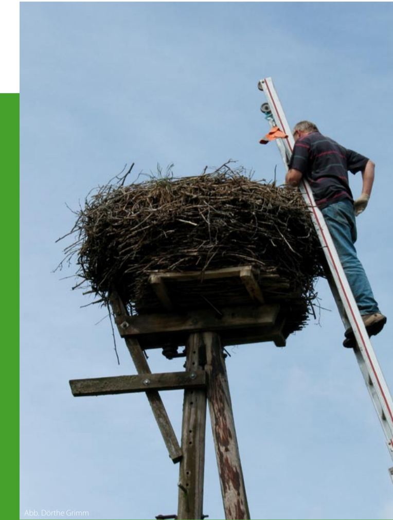
Bei etwas niedrigeren Masten wird auf den Hubwagen verzichtet, stattdessen muss auf die Leiter gestiegen werden. Schwindelfrei müssen die Beringer schon sein.
